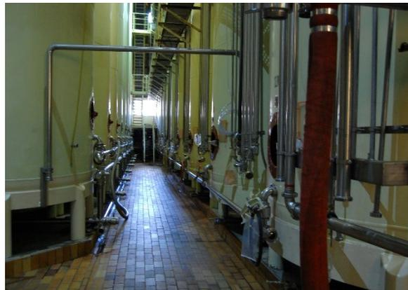
Sa capacité de réception des différents raisins est énorme : les raisins sont sélectionnés par village (68 villages, anciennement plus de 90), par cru, et ensuite pressés et transférés dans des cuves via un système de tuyaux qui permettent par rotation l'évacuation de tous les petits déchets. Elle dispose de 6 conteneurs en acier inoxydable de 1.200.000 L, de 12 conteneurs de 600.000 L, de 40 conteneurs de 60.000 L.
